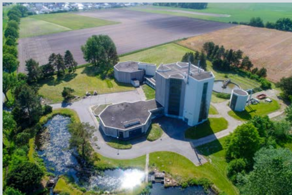
Das Wasserwerk in Rühren
