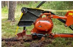
Ein leistungsstarker Pflug gräbt die 1,20 Meter tiefe Furche in die Erde. Das Stromkabel gelangt über einen Trichter direkt auf den Boden des schmalen Grabens.
