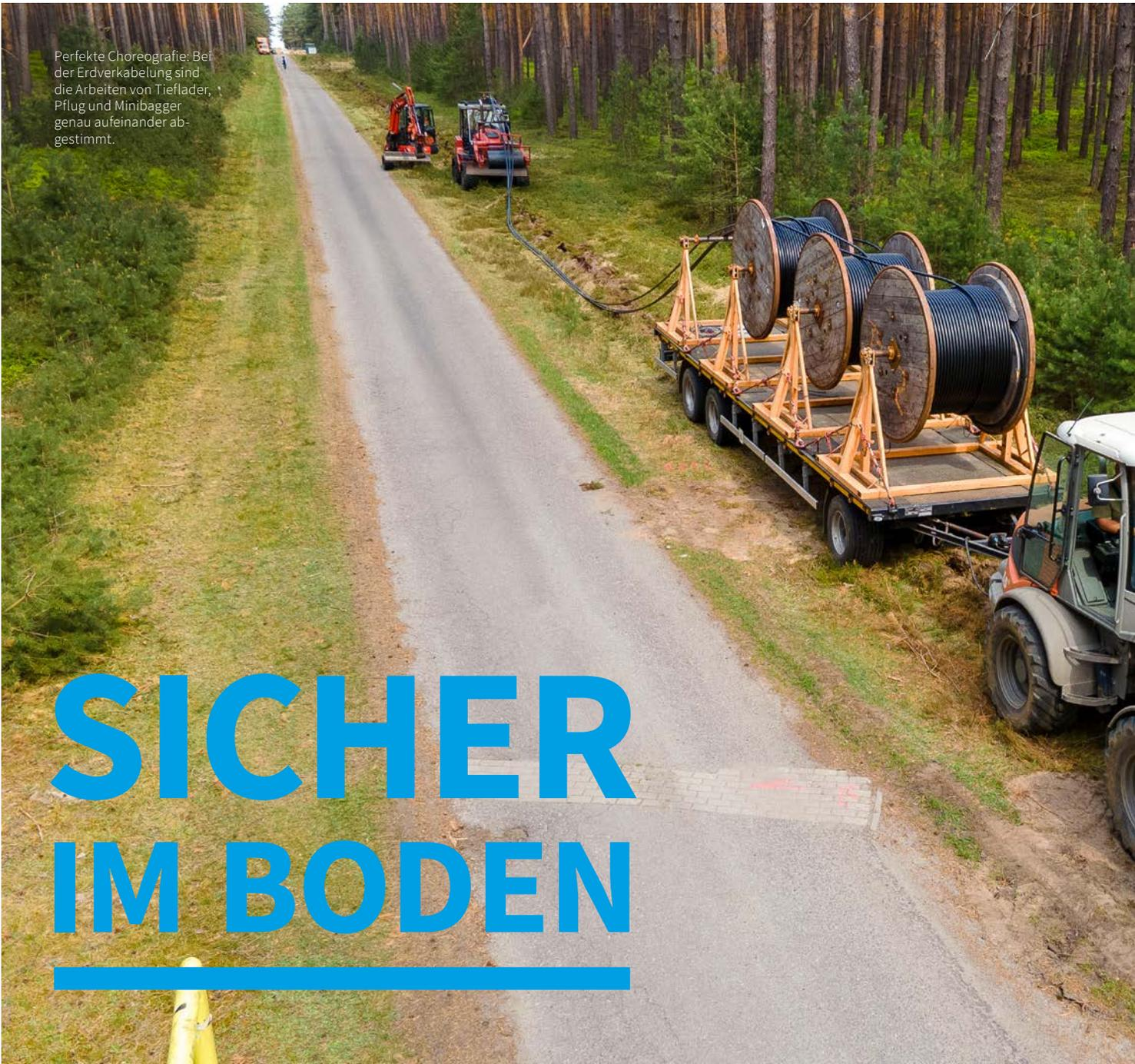
Perfekte Choreografie: Bei der Erdverkabelung sind die Arbeiten von Tieflader, Pflug und Minibagger genau aufeinander abgestimmt.
