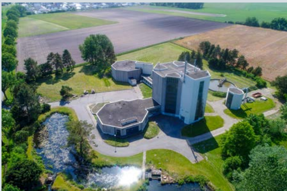
Das Wasserwerk in Rühren
