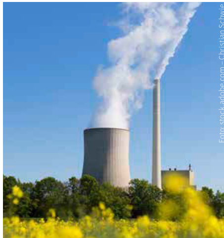
Charakteristisch für ein Kohlekraftwerk: Über den Kühlturm (links) wird die überschüssige Kondensationswärme abgeleitet. Über den Schornstein (rechts) entweichen umweltschädliche Abgase, darunter auch das farblose Kohlendioxid.
