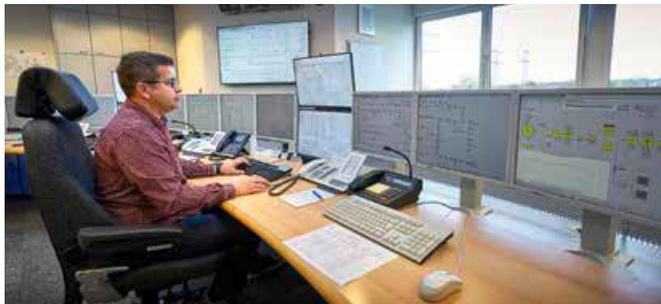
In der Netzleitstelle der LSW laufen alle wichtigen Netzdaten zusammen. Sie ist 24/7, an jedem Tag im Jahr, besetzt und sorgt für eine zuverlässige und sichere Versorgung mit Strom, Erdgas, Fernwärme und Wasser.
