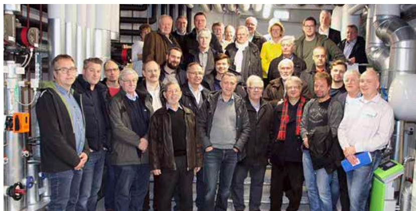
Weiterbildung vor Ort: Tobias Göring (rechts), Geschäftsführer der Elektrogemeinschaft, führte die Mitglieder durch die hochmoderne Technikzentrale des Wolfsburger Nordkopf Towers.
